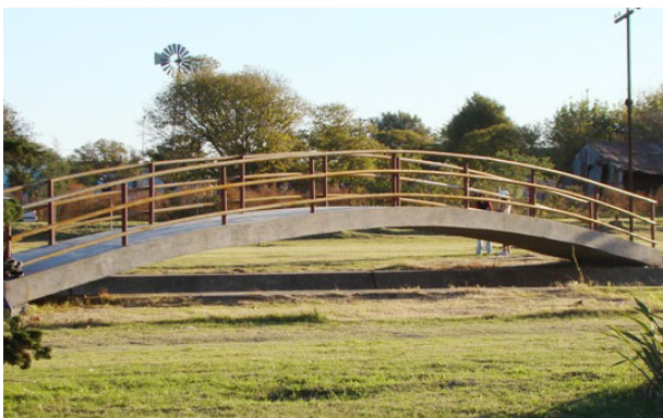
El puente sobre el canal ya está prácticamente terminado.
